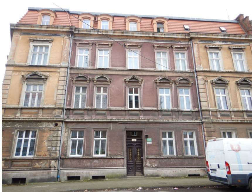
Ogólny widok budynku
